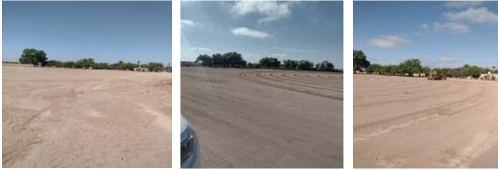
Acondicionamiento del Campo de Béisbol de Buena Vista, San Ignacio
