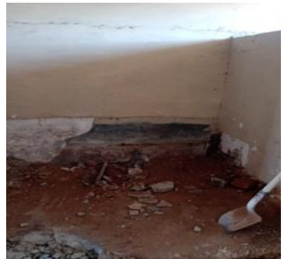
Rehabilitación del kiosco del Trébol de la Categoría 15-16 (engarrado, pintado de paredes, introducción de tubería).
