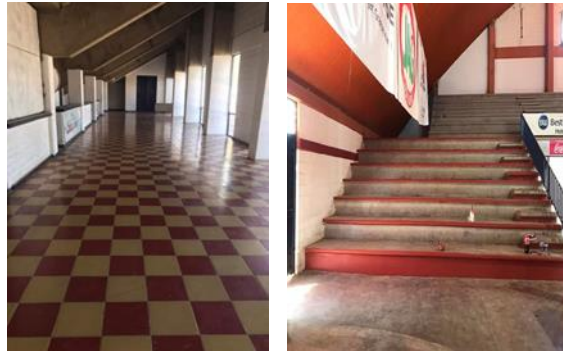
Trabajo de Pintura y mantenimiento en el Gimnasio Armando Islas Covarrubias
