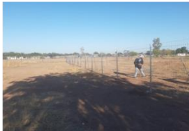
Arreglo de cerca perimetral del campo 4 de béisbol
