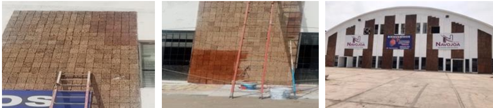
Tratamiento, limpieza y pintado a cantera del Gimnasio municipal Armando Islas Covarrubias en la parte principal.
