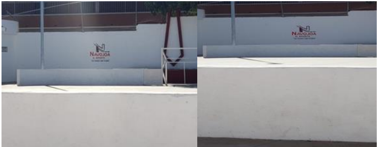
Rehabilitación de Cancha Municipal (Pintado y Saneamiento de paredes en mal estado).
