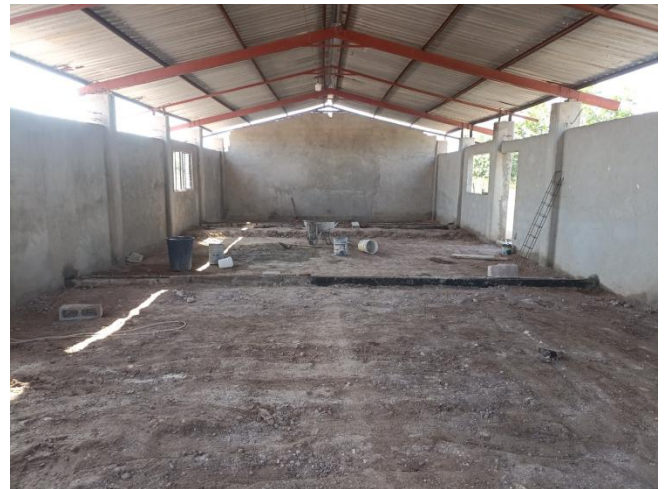
REHABILITACIÓN GENERAL DE IGLESIA DE DIOS EN MÉXICO A.R., LOCALIDAD DE PUEBLO MAYO
